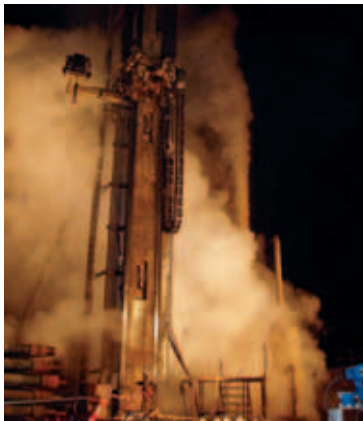
Fündigkeit: 150 l/s; 122° C Drilling Success: 150 l/s; 122° C
